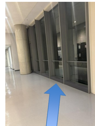
14号館共用部廊下 PC用テーブル設置
