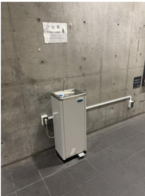
14号館共用部冷水器設置 (増設含む)
